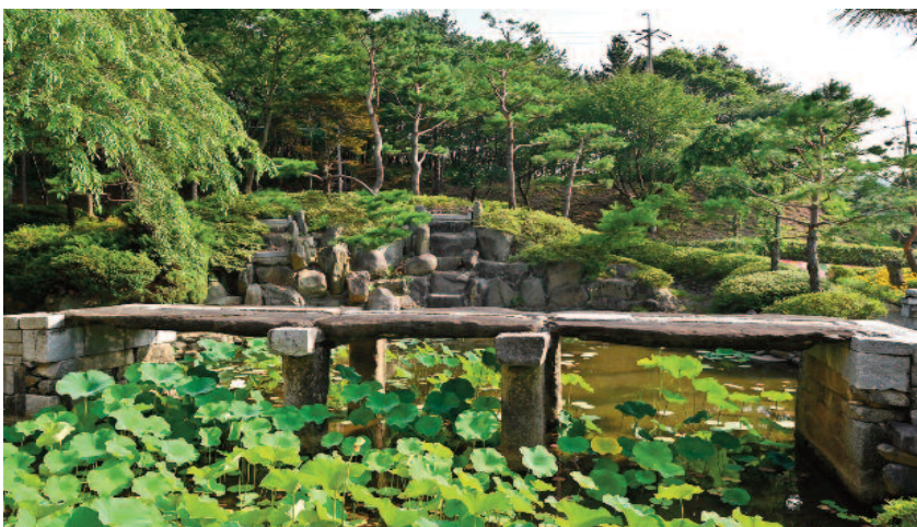
수해로 유실됐던 군북면 증악리 청석교를 장계관광지로 옮겼다.
